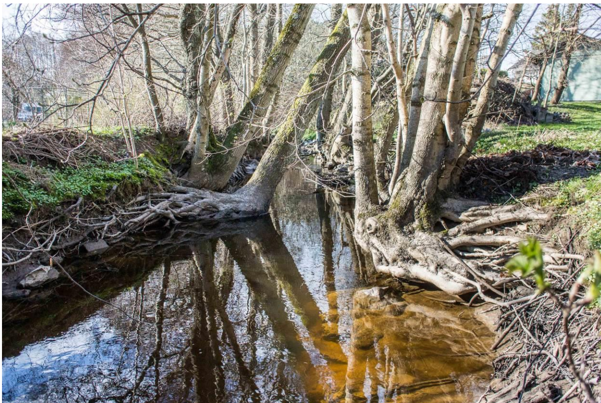
Figur 21. Foto 4723, Erosion har underminerat träden och blottat rotsystem.
