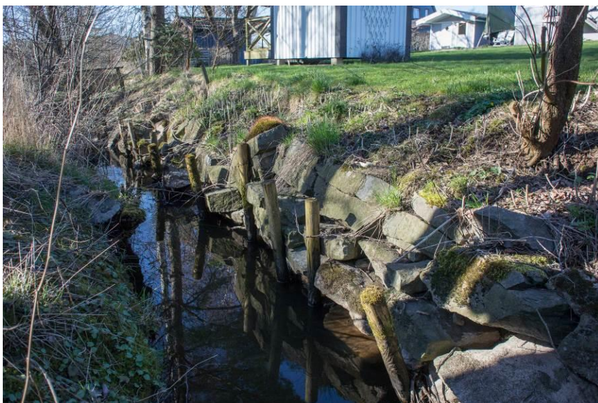
Figur 8. Punkt 4570, Stolpar för att hålla emot underminerat skydd.
