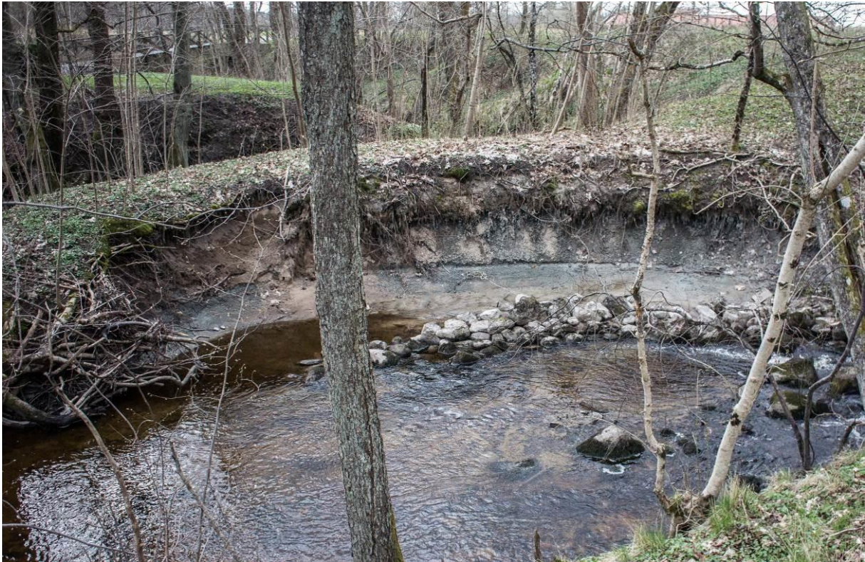
Figur 20. Fotpunkt 4717. Urspolat erosionskydd intill kyrkogården.
