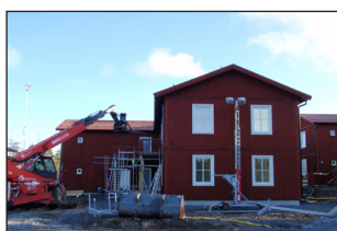
Byggnation i Kronogården, Älvängen.
