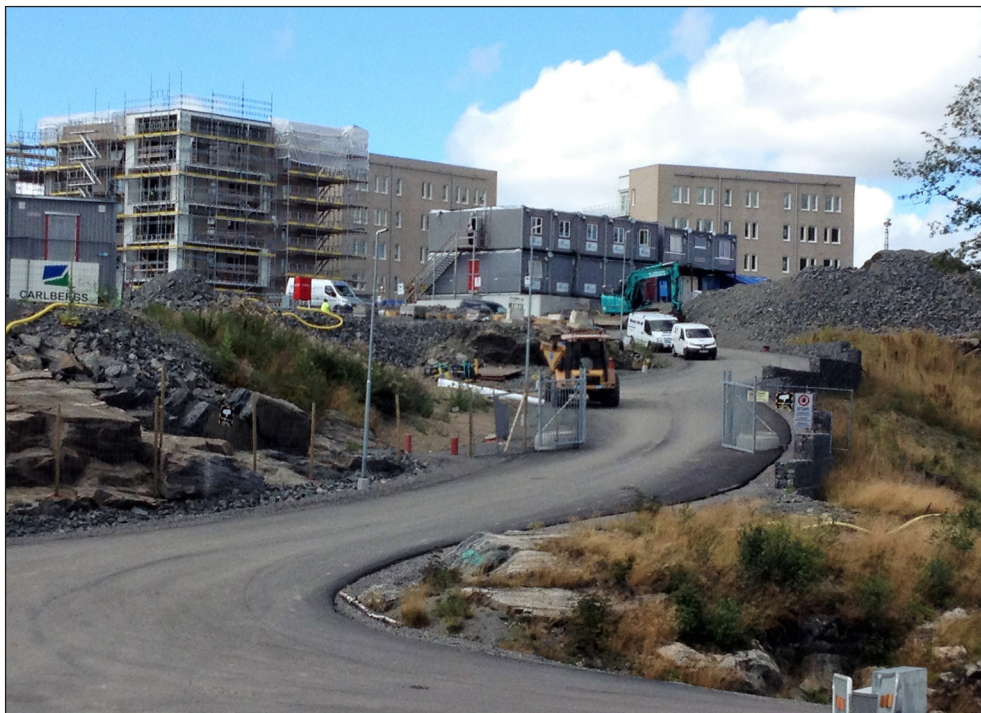
Byggnation vid Keillers damm i Surte.
