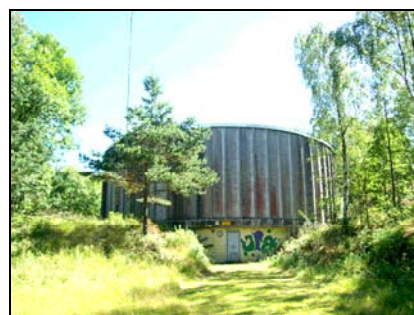
Vattenreservoar vid Lunnavägen
