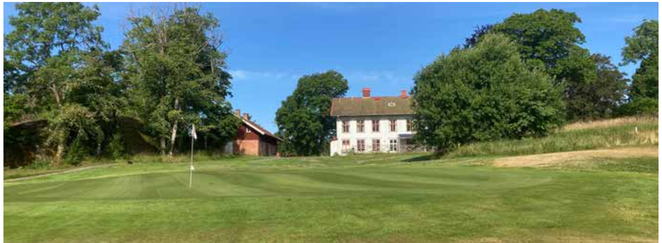
Siktlinje mot huvudbyggnad och mejeribyggnad från golfbanan i öster.
