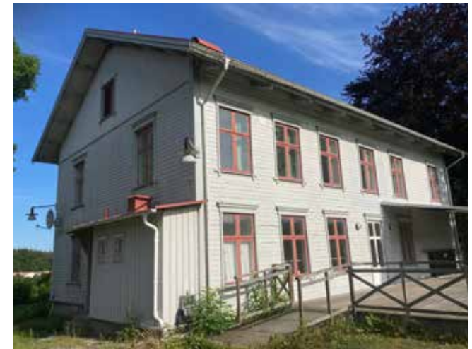
Huvudbyggnaden, södra och östra fasaden.
