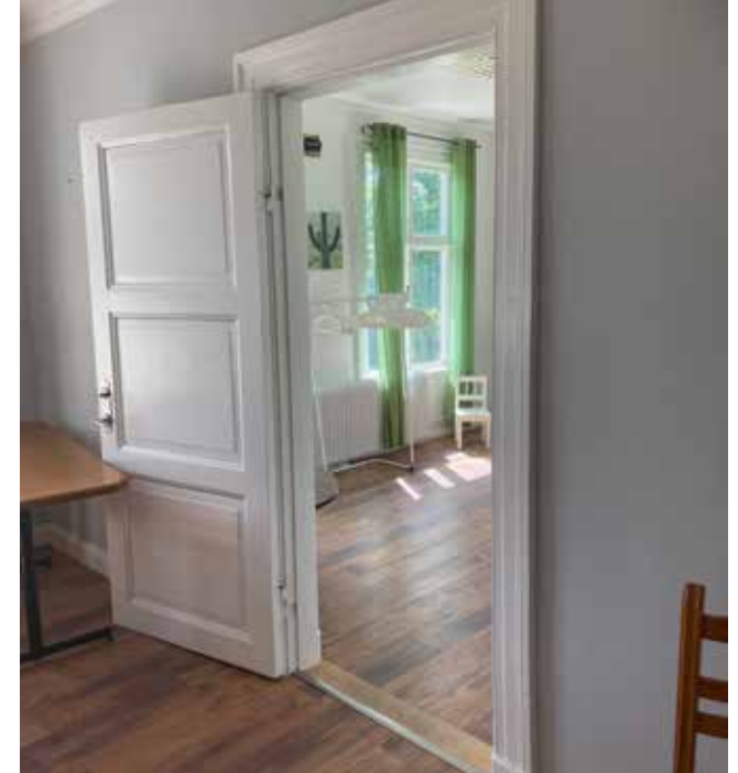
Interiört finns flera bevarade halvfranska spegeldörrar med dörromfattningar från slutet av 1800-talet.
