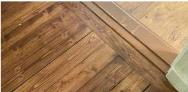
Bevarad tröskel i huvudbyggnaden. Till vänster det äldre trägolvet. Till höger ett senare lagt golv som finns i vissa rum. Av nivåerna att döma är det nya golvet lagt ovanpå det äldre golvet.
