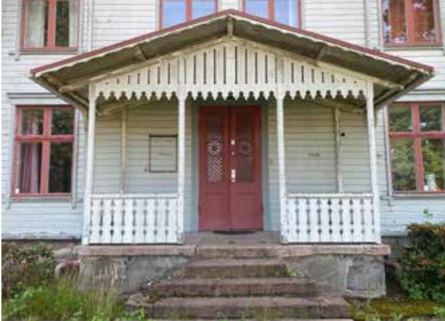
Huvudbyggnadens farstukvist präglas av "snickarglädje". I fönsterdörrens spröjsverk är säteriets symbol integrerad.
