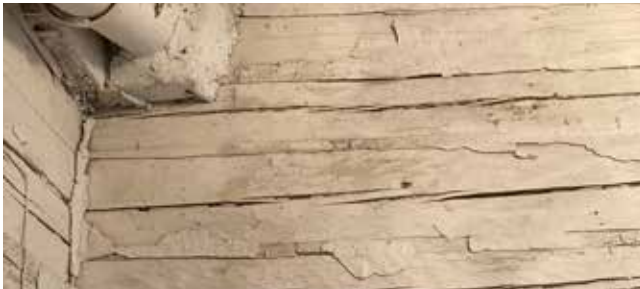
Bild från husets källare där den ursprungliga timrade stommen framträder.
