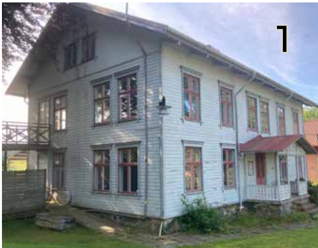
Säteriets huvudbyggnad, norra och västra fasaden.
