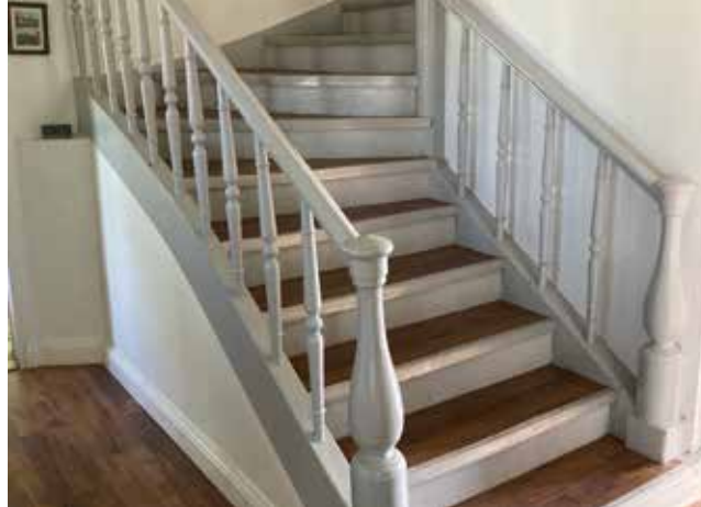
Huvudbyggnaden. Trappan i hallen är helt i original från 1800-talets slut bortsett från planstegens ytskikt.
