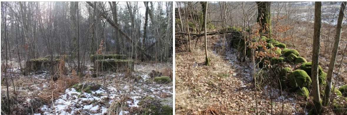
Figur 18. betongfundament (till vänster) och gärdesgården (till höger)
