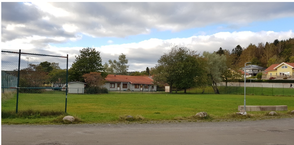
Del av fastighet Nol 2:145 – Nolängens förskola och bollplan
