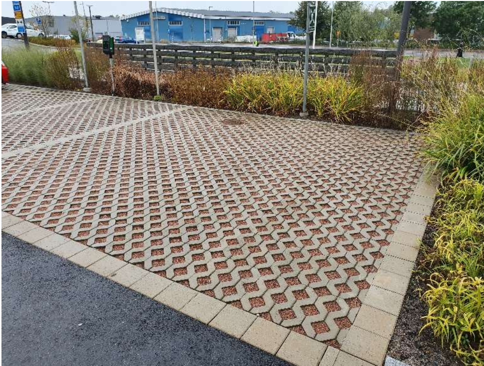
Figur 14. Exempel på infiltrationsyta med grusarmering (foto: Tyréns AB).
