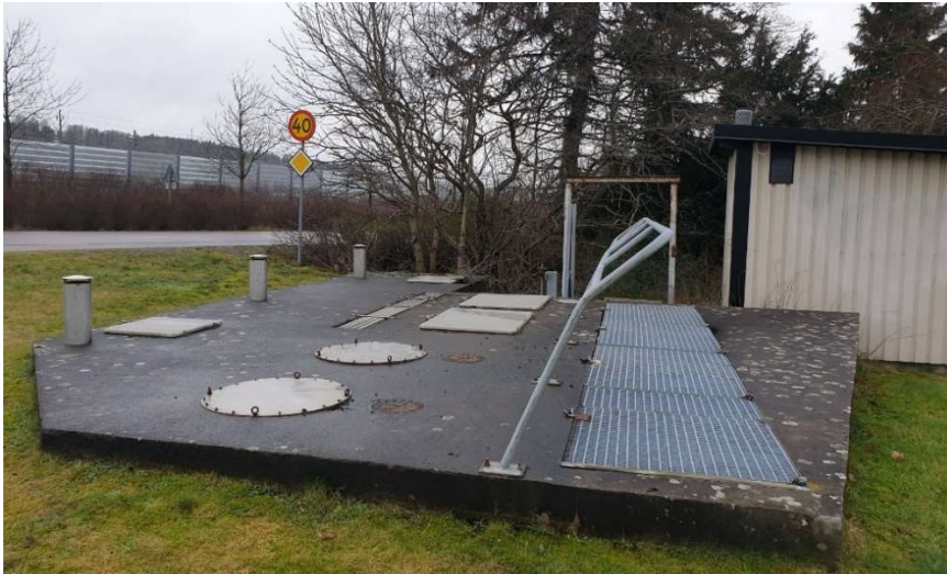
Figur 5. Dagvattenpumpstation väst om planområdet, utmed väg E45, källa Tyréns.
