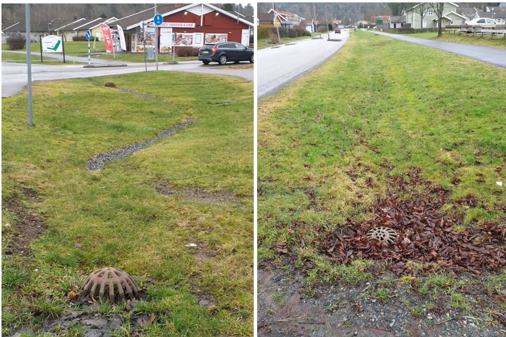
Figur 6. Svackdike utmed södra delen av Gallåsvägen, källa Tyréns.
