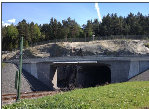
Bild 13: Den norra tunnelmynningen med bilbro som korsar järnvägen.
