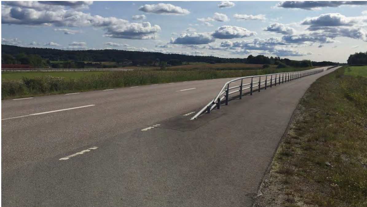
Figur 9. Räcke mellan körbana och gång- och cykelväg på väg 2002.
