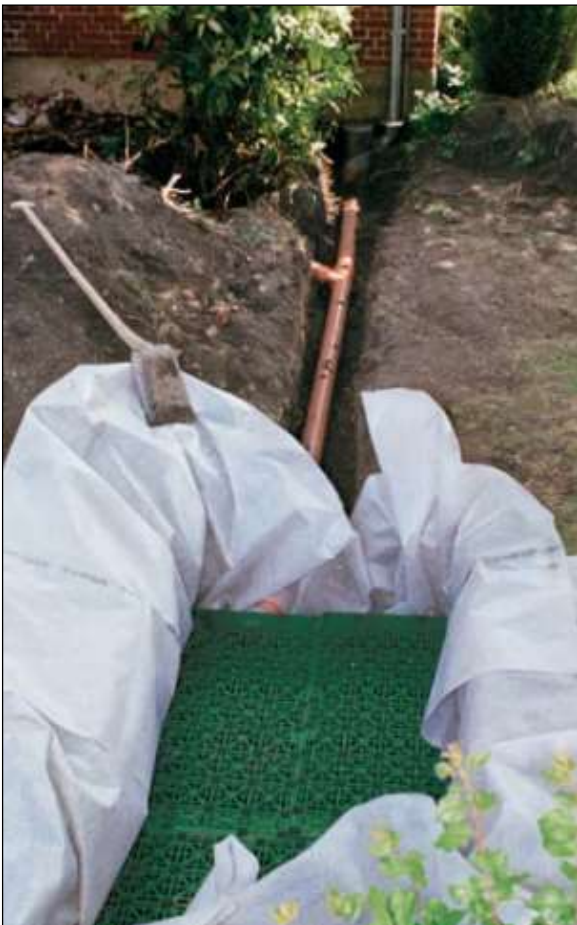
Figur 13. Exempel på utjämningsmagasin bestående av dagvattenkassetter.
