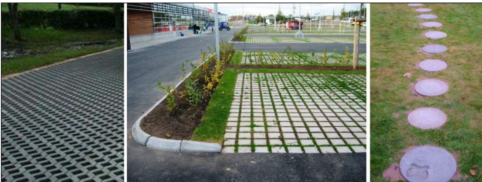
Figur 12. Ytor med hålsten av betong samt gångstig med gräs och gångplattor.
