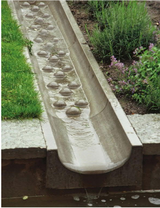
Figur 29. Exempel på ytlig avledning av dagvatten i Augustenborg.
