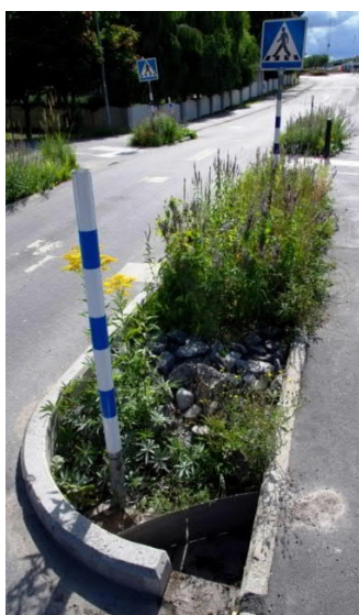
Figur 18. Exempel på regnbädd i gatumiljö. Bildkälla: Dagvattenguiden.se
