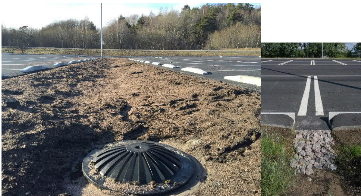
Figur 14. Exempel på nyanlagd översilningsyta från parkering. Foto: Per Norberg och Peter Svensson (smhi.se)
