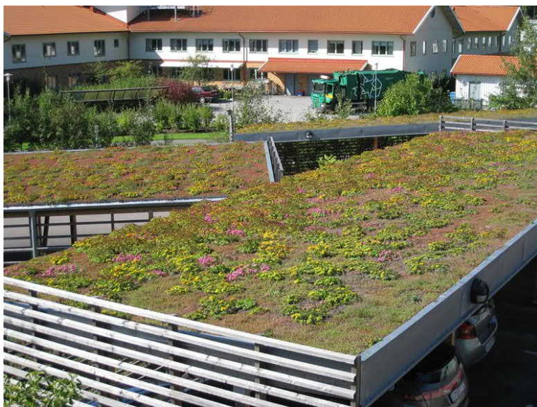
Figur 27. Grönt sedumtak på garagebyggnad i Kungsbacka. Bildkälla: VegTech AB.
