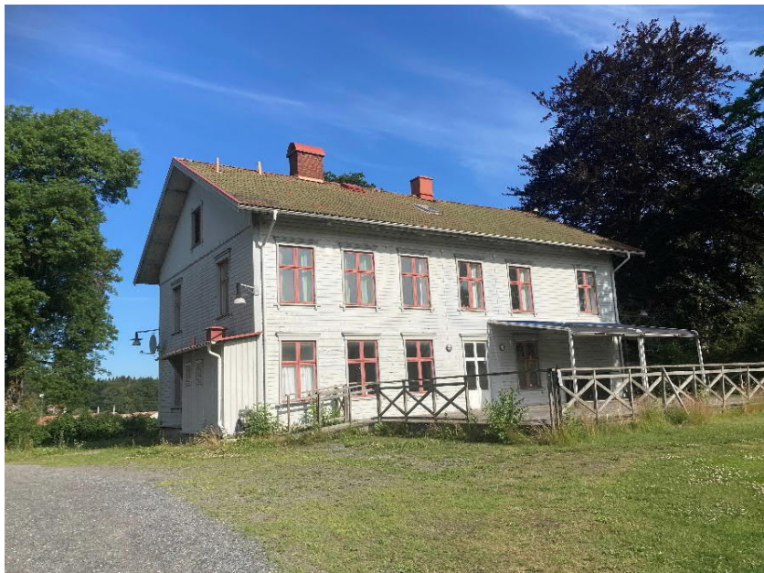
Figur 14. Huvudbyggnaden i Säteriet. Foto: WSP
