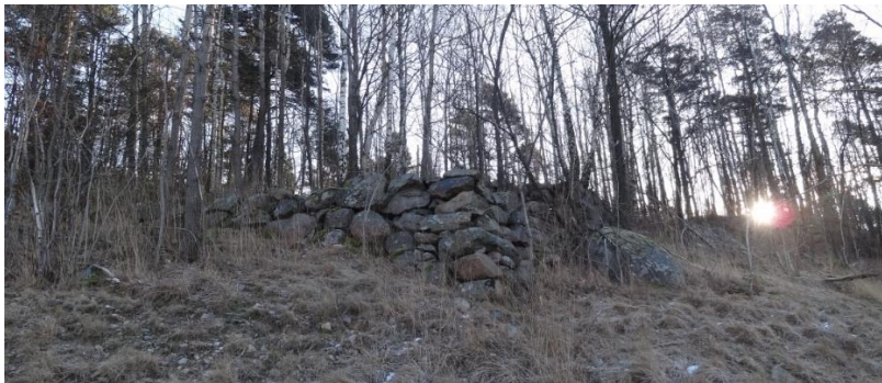
Figur 15 Fundament för linbana vilken skulle förbinda Denofaområdet med kajen vid Göta älv (Västarvet 2013).
