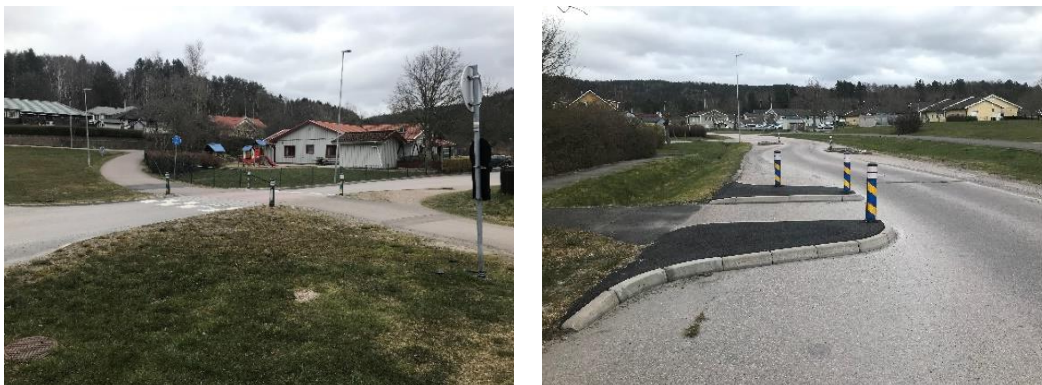
Figur 7: Befintlig förhöjd gång- och cykelpassage vid förskolan samt chikaner längs Gallåsvägen
