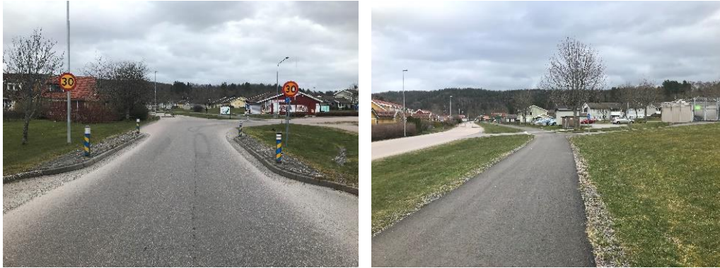
Figur 4: Avsmalning vid område för 30 km/h samt gång- och cykelbana längs Gallåsvägen
