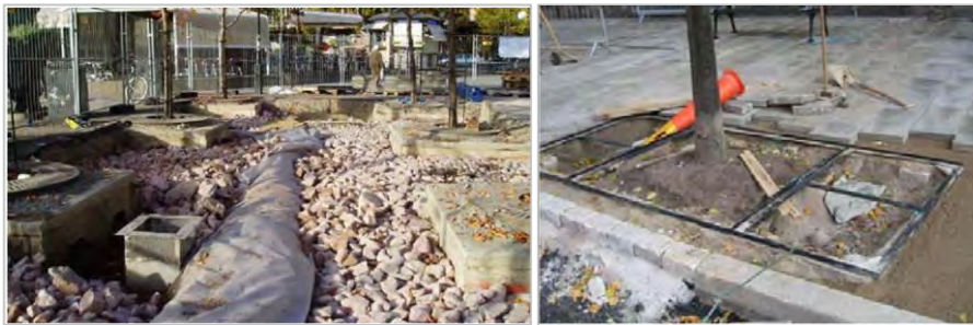
Figur 2. Makadamlager och utplacering av trädgallerram. Foto: Björn Embrèn, Anders Ohlsson Sjöberg.
