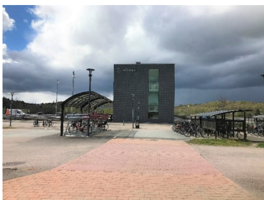
Pendelstationen, i riktning mot väster
