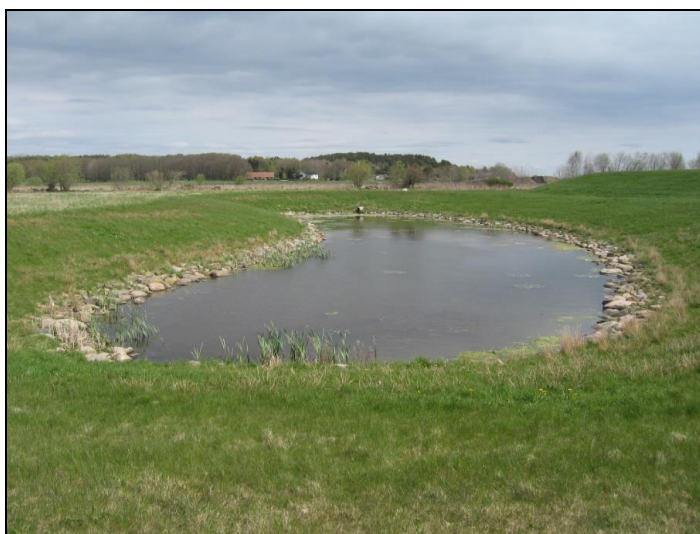
Figur 8. Fördröjningsdamm (Foto: Norconsult)
