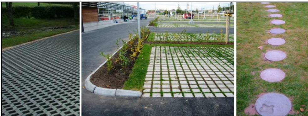
Figur 3. Ytor med hålsten av betong samt gångstig med gräs och gångplattor
