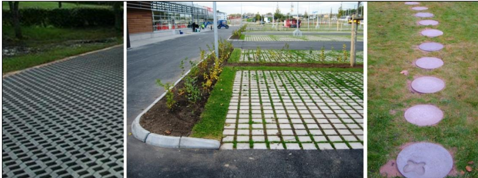
Figur 16. Ytor med hålsten av betong samt gångstig med gräs och gångplattor.
