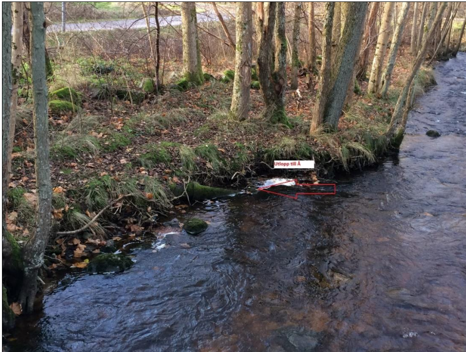
Figur 12. Utlopp från dagvattenledning väster om Bräckans väg. (Bildkälla: Ale kommun)
