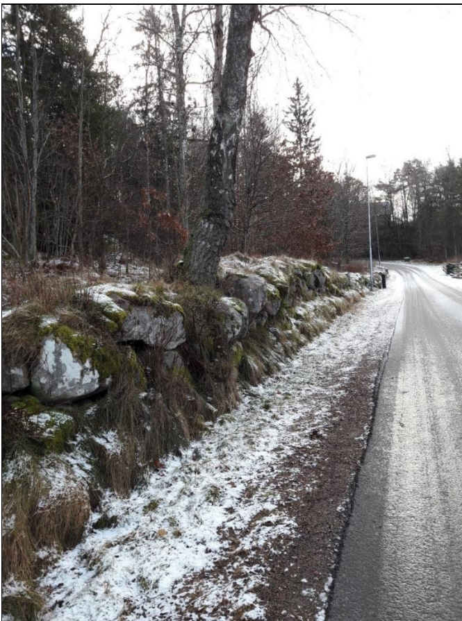
Figur 11. Svackdike längs med Bräckans väg i höjd med Stommen 7:1.
