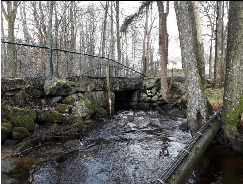
Figur 7. Gångbro över Hålldammsbäcken.
