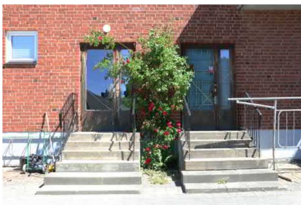
Entrépartier på baksidan.
