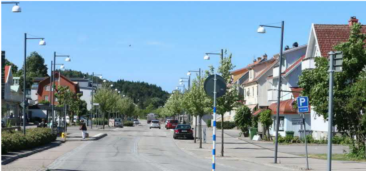
Viktig vy i Älvängens tätort med upprustad gata och bebyggelsen som vänder sina småskaliga butiker mot gatan. Gatan med nyplanterade träd, parkering och trottoarer utgör tätortens kommersiella nav. Gatans byggnader speglar utvecklingen från slutet av 1800-talet till 2000-talet.
