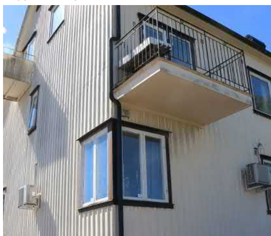
Fönster över hörn och ursprunglig balkong.
