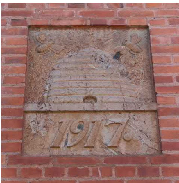
Inmurad platta med byggår.
