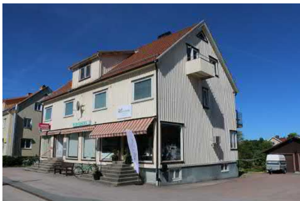
Fasad mot Göteborgsvägen. Pyramidformade trappor till butikerna.
