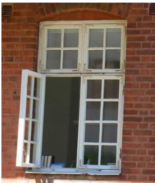
Äldre småruttspröjsat fönster.
