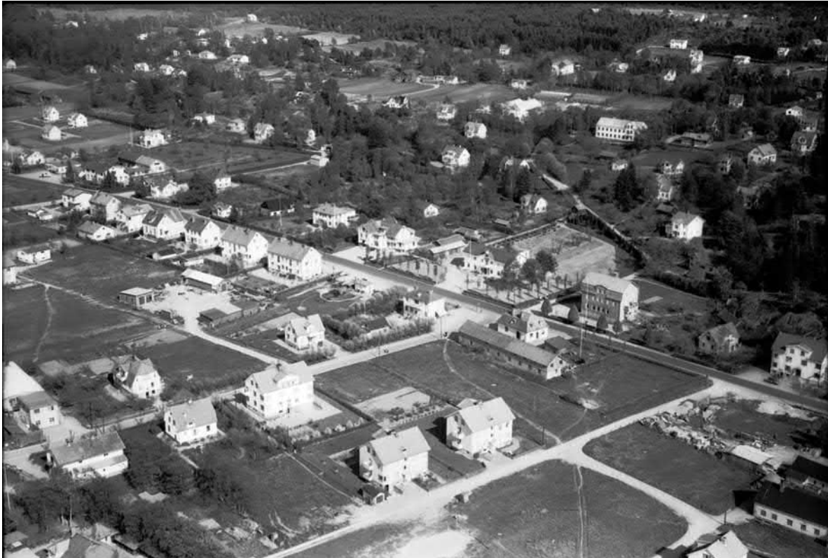
1955. Älvängen har fått flera ljusmålade tvåvåningshus. Lägg speciellt märke till den täta raden av nybyggda hus utmed Göteborgsvägen.
