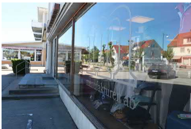
Äldre skyltfönster med stålprofiler.
