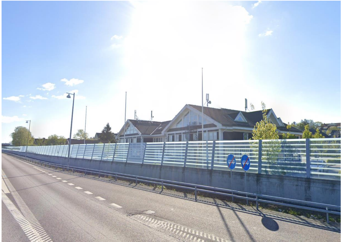
Figur 7: Avvåkningsräcke och bullerskydd mellan planområde och E 45
